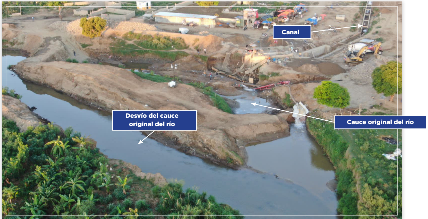
Vista actual del proyecto de construcción, octubre 2023.
